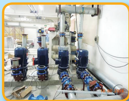
配套水泵及管道安裝
